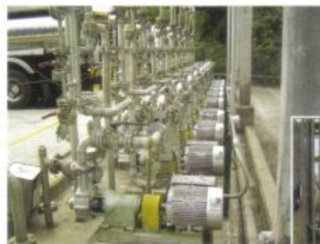
薬品製造工場
